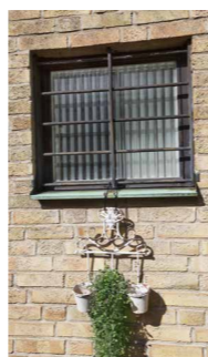
Lennart och Harrieth Hallén bor i det som tidigare varit häktet. På några av fönstren är det fortfarande järngaller!
